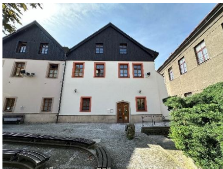
Dlouhá 96 – opravená fasáda
