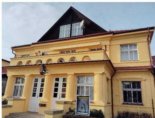
vstupní část divadla po nátěrech a výměně klempířských prvků
