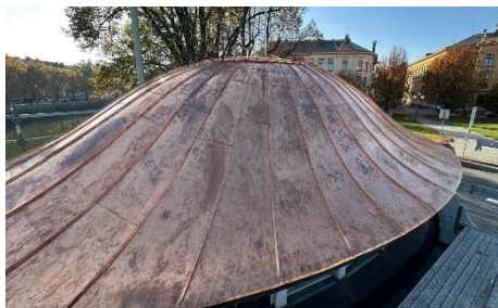
střecha po opravě
