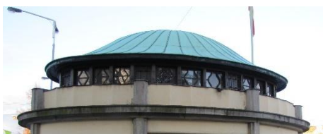
střecha – původní stav
