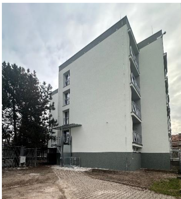
stavba těsně před dokončením, pohled na zdvižnou plošinu
