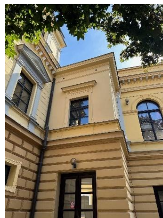
Dlouhá 98 – opravená římsa
