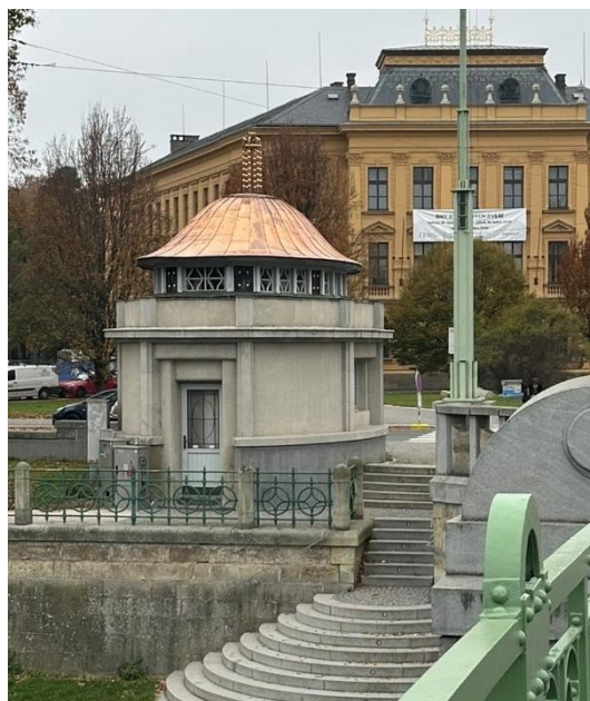
kiosk č. 3 s opravenou střechou a ozdobnou „fontánou“
