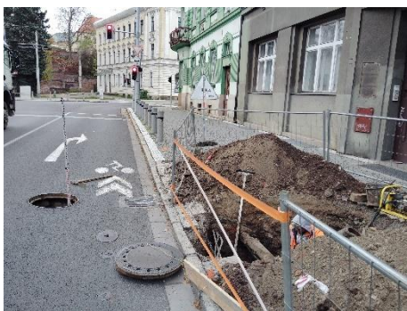
napojování dešťových svodů do kanalizace
