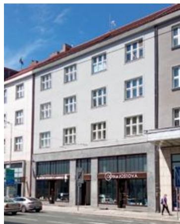
po výměně výloh a opravě fasády
